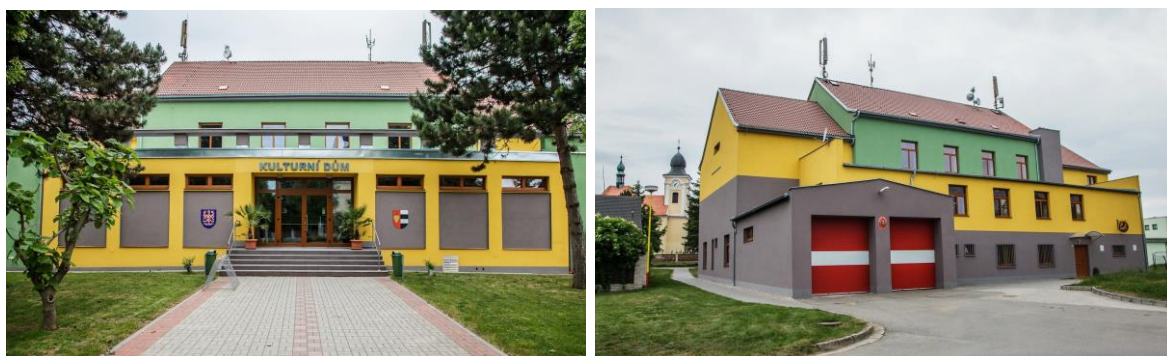
Obrázek č. 6 a obrázek č. 7: Kulturní dům v obci Prušánky
