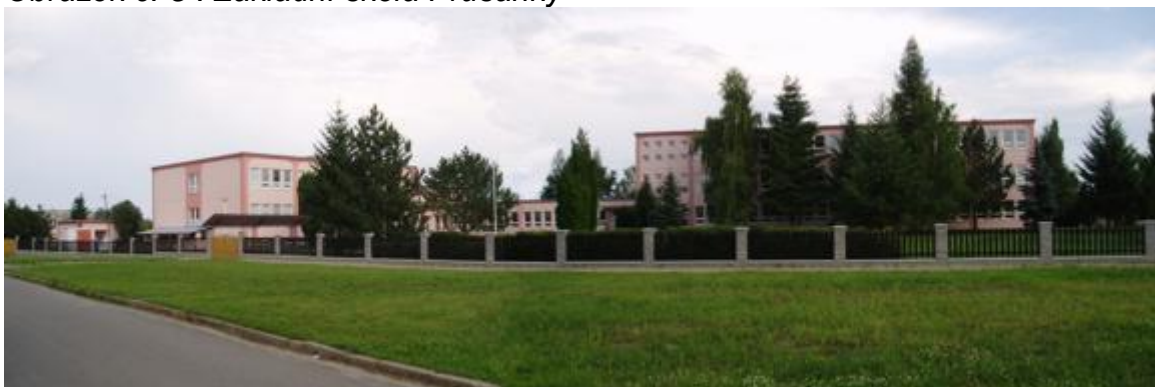
Obrázek č. 5 : Základní škola Prušánky
